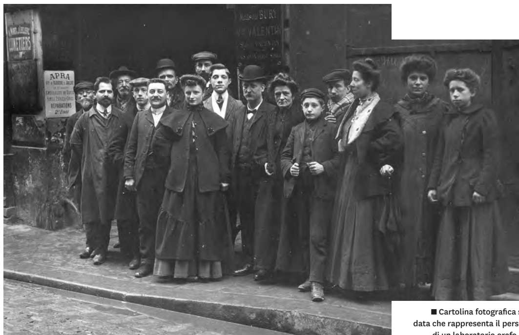
■ Cartolina fotografica senza data che rappresenta gli operai di un cantiere di lavori pubblici Avenue de La Bourdonnais, Parigi 7° arrondissement © Collezione AF.
